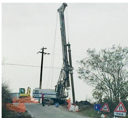
È iniziato il cantiere del Consorzio Bonifica Renana, per il consolidamento del versante della scarpata di Via Tolara di sopra (nei pressi della Pieve di Pastino) interessato dallo smottamento, con le perforazioni per la realizzazione del cordolo.
